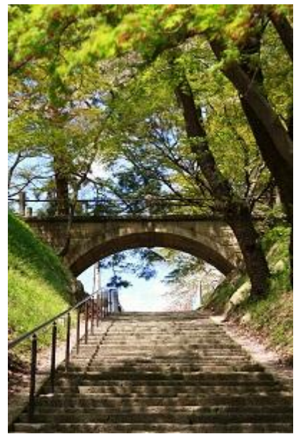
烏帽子山八幡宮参道に作られた立体交差型の康寿橋
