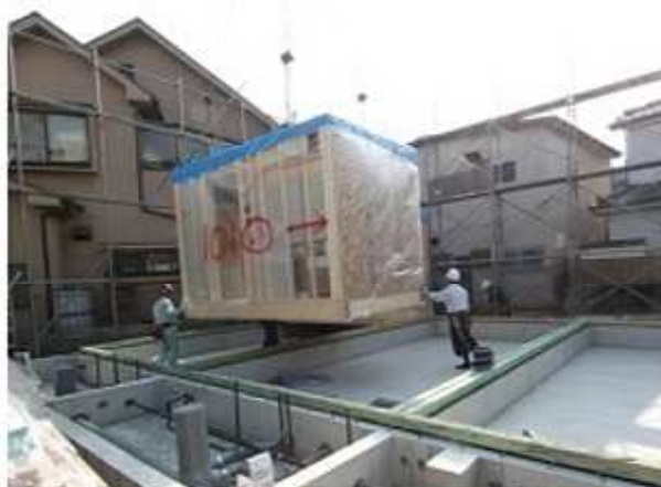
ユニット設置
