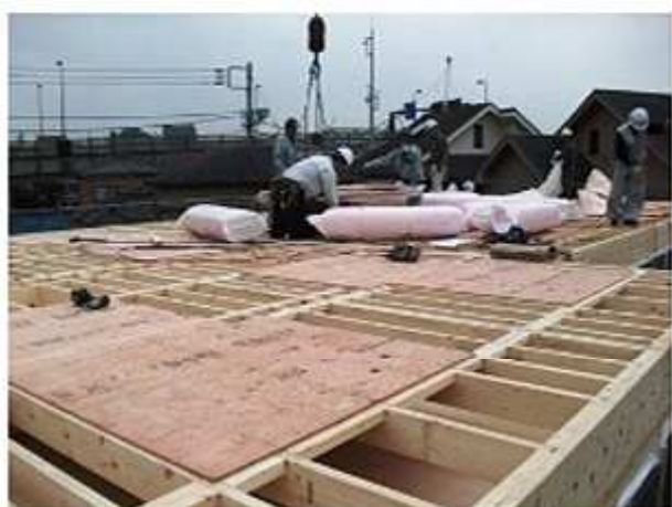
屋根パネル施工
