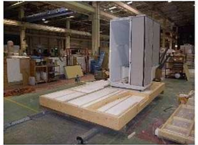
ユニットバス設置
