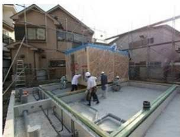
ユニット設置
