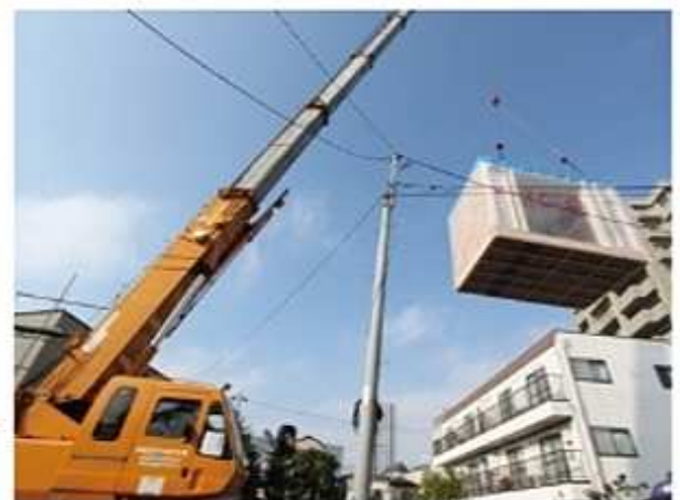
ユニット吊り上げ
