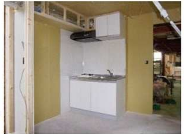
設備取り付け
