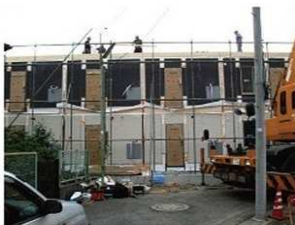
全ユニット設置完了
