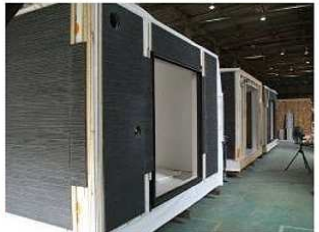
内装・サイディング施工
